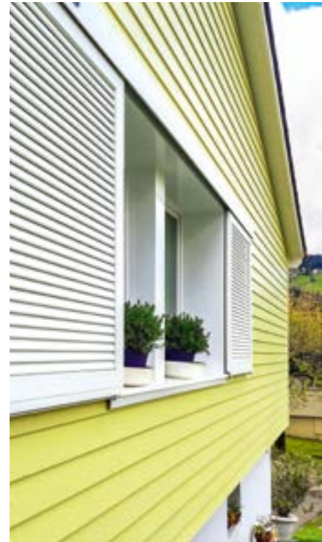
Im Rahmen der Sanierung der Fassade sind auch Wärmebrücken ausgemerzt worden.
