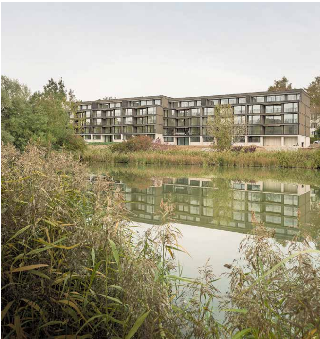
Das Gebäude mit seiner Holzfassade integriert sich auf eine natürliche Weise ins Naturschutzgebiet Bildweiher.
