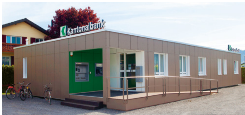
Provisorische Lösungen bei Umbauten
